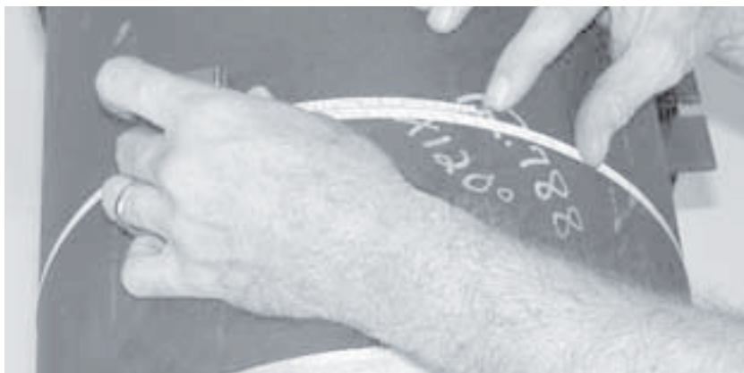
Рис. 5-3. Проверьте окружность трубы измерением.
