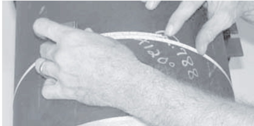
Abbildungen 5-3. Überprüfen Sie den Rohrumfang durch Nachmessen.
