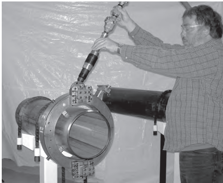
Рис. 2-8. При управлении НППА с передней стороны необходимо располагаться сбоку агрегата для использования управляющих рычагов без необходимости тянуться через вращающуюся платформу.
