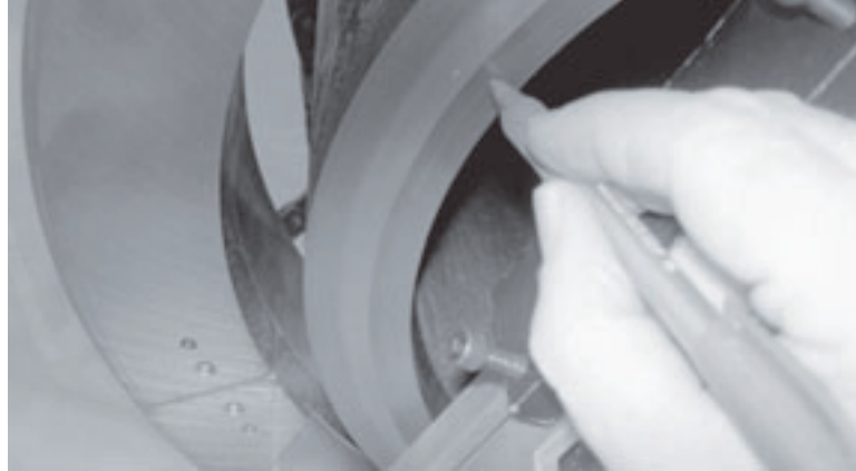
Рис. 3-57. Отметьте расположение верхней грани фаски на поверхности трубы для контроля приближения агрегата к заключительному проходу.
