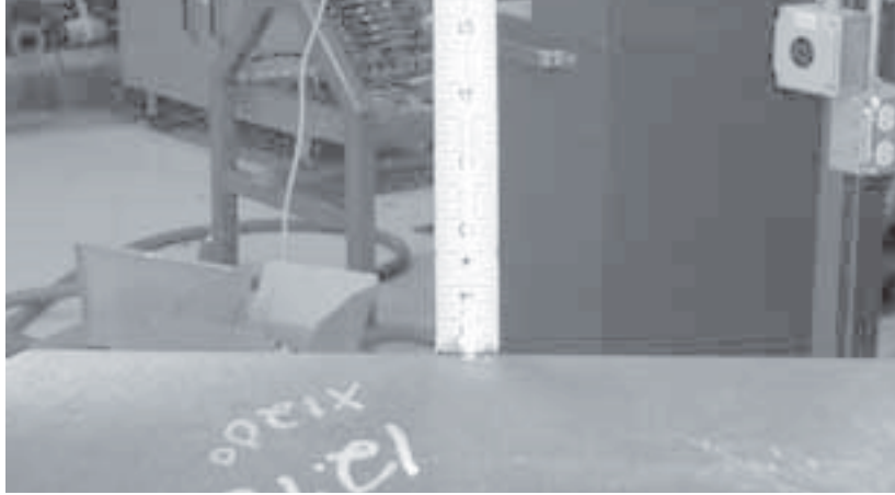
Figure 5-1. Mesurez l'espace radial libre autour du tuyau.
