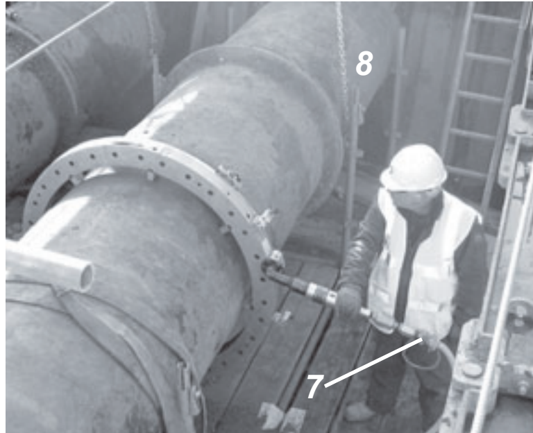
Figure 2-2. Dangers potentiels d'utilisation de la machine LCSF. Voir les descriptions ci-dessous.
