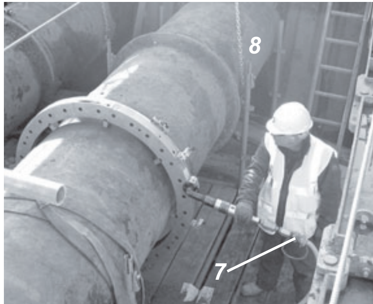
Figura 2-2. Riesgos operativos potenciales de la LCSF. Consulte las descripciones a continuación.
