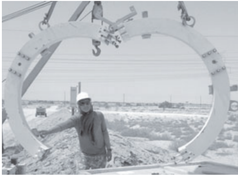
Рис. 3-1. На изображении показан высокопрочный разъемный агрегат, раскрытый для установки на трубе в составе трубопровода.
